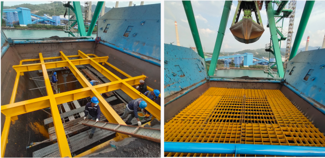
JASA PERBAIKAN DAN PEMASANGAN SCREEN HOPPER SHIP UNLOADER 2 PT PLN Indonesia Power Suralaya PGU
