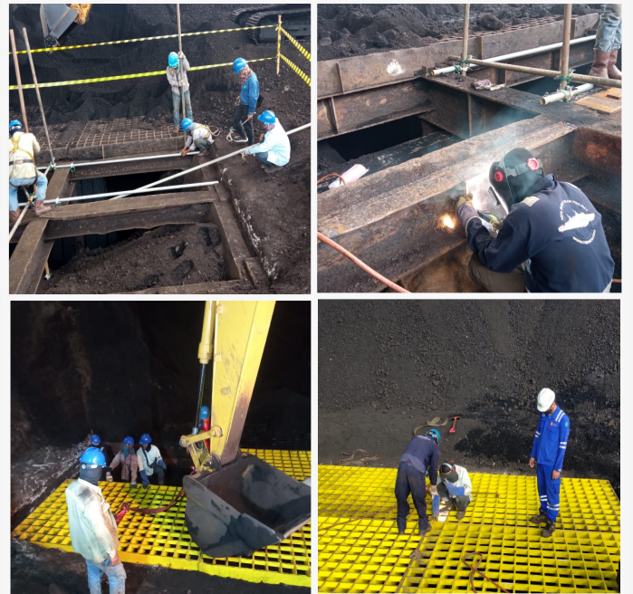
JASA PENGGANTIAN DAN PEMASANGAN SCREEN HOPPER D PT PLN Indonesia Power UBP Suralaya
