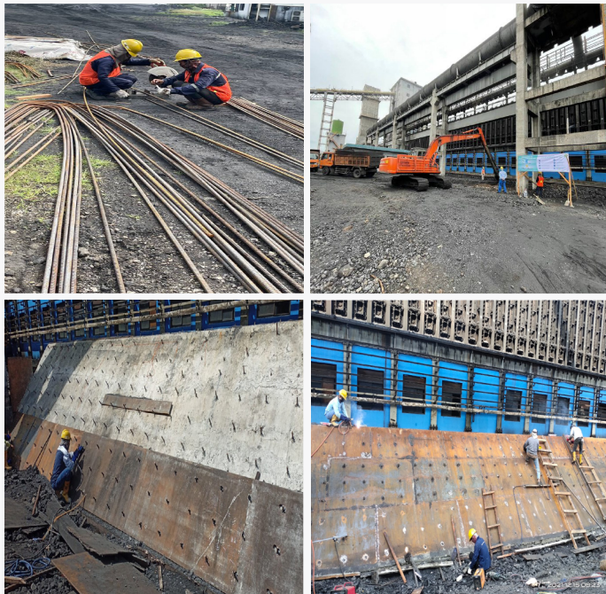
PEMBANGUNAN EMERGENCY COKE WHARF PT Krakatau Steel (Persero) Tbk.
