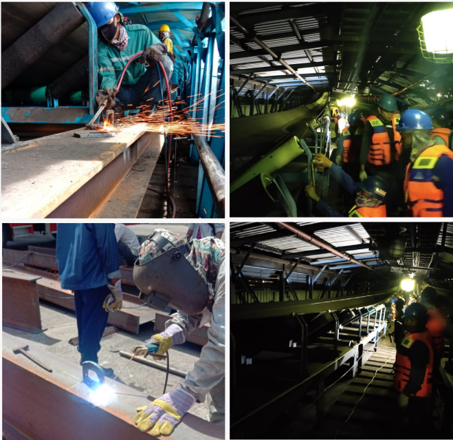
PERBAIKAN BC 34 & 35 DERMAGA PT PLN INDONESIA POWER SURALAYA PGU PT Hutama Karya (Persero) Divisi EPC
